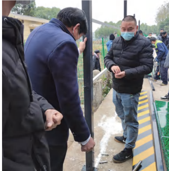
武汉东新区曙光学校工程围挡施工
