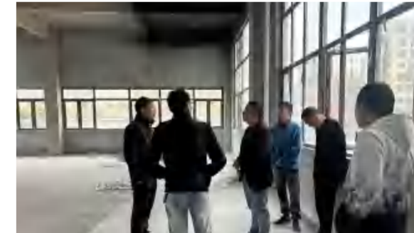
4月23日, 董事长杜勇在中信仁和制造基地项目特校装修工程现场研究工程进度安排并作技术指导(程世兵摄)
